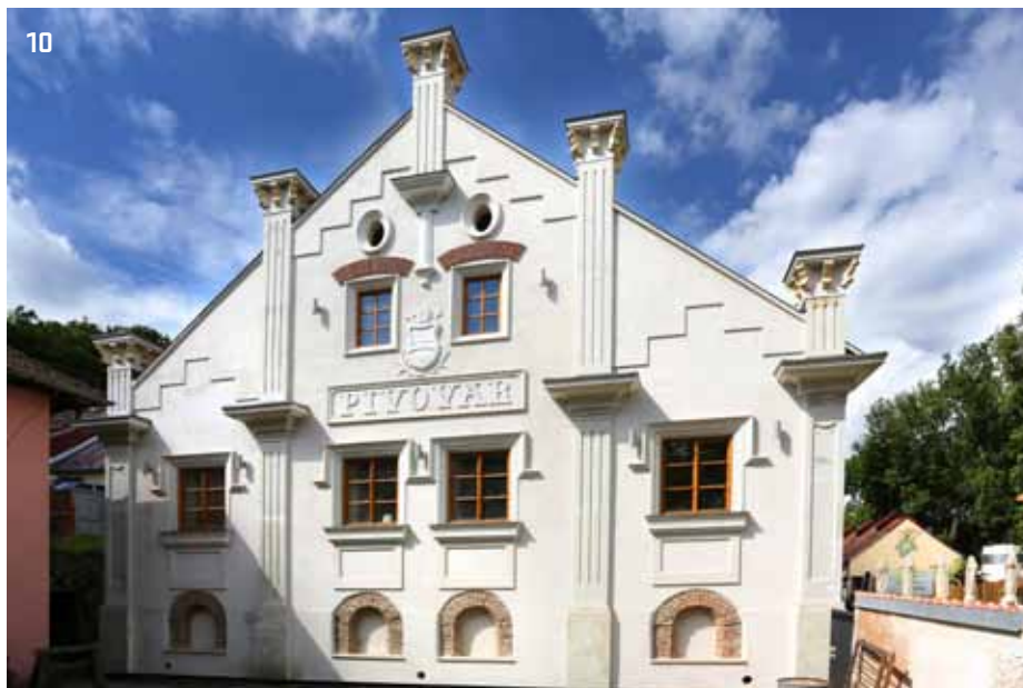
10 > Průčelí pivovaru prošlo důslednou rekonstrukcí včetně historických detailů
